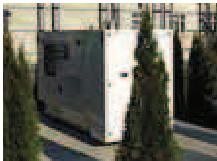
Kültéri tokozott [zajcsillapítás] aggregátor
